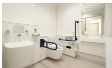
横浜工場事務所棟 バリアフリー
