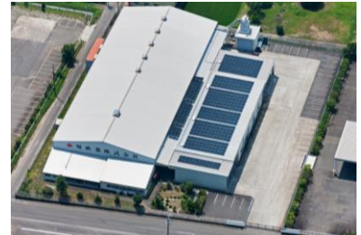
藤枝工場 太陽光発電設備
