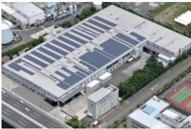
横浜工場 太陽光発電設備
