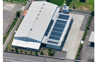
藤枝工場 太陽光発電設備
